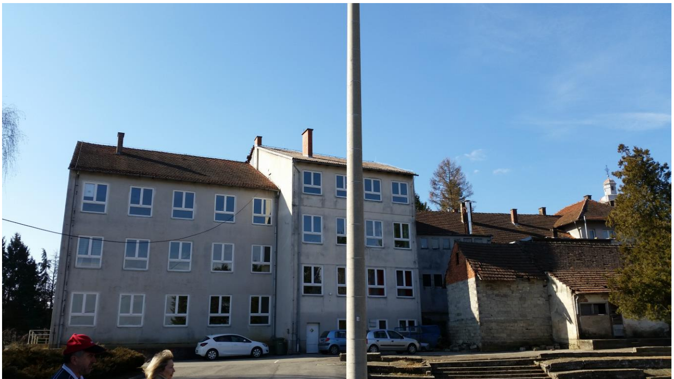
SJEVERO PROČELJE - NOVIJI DIO
