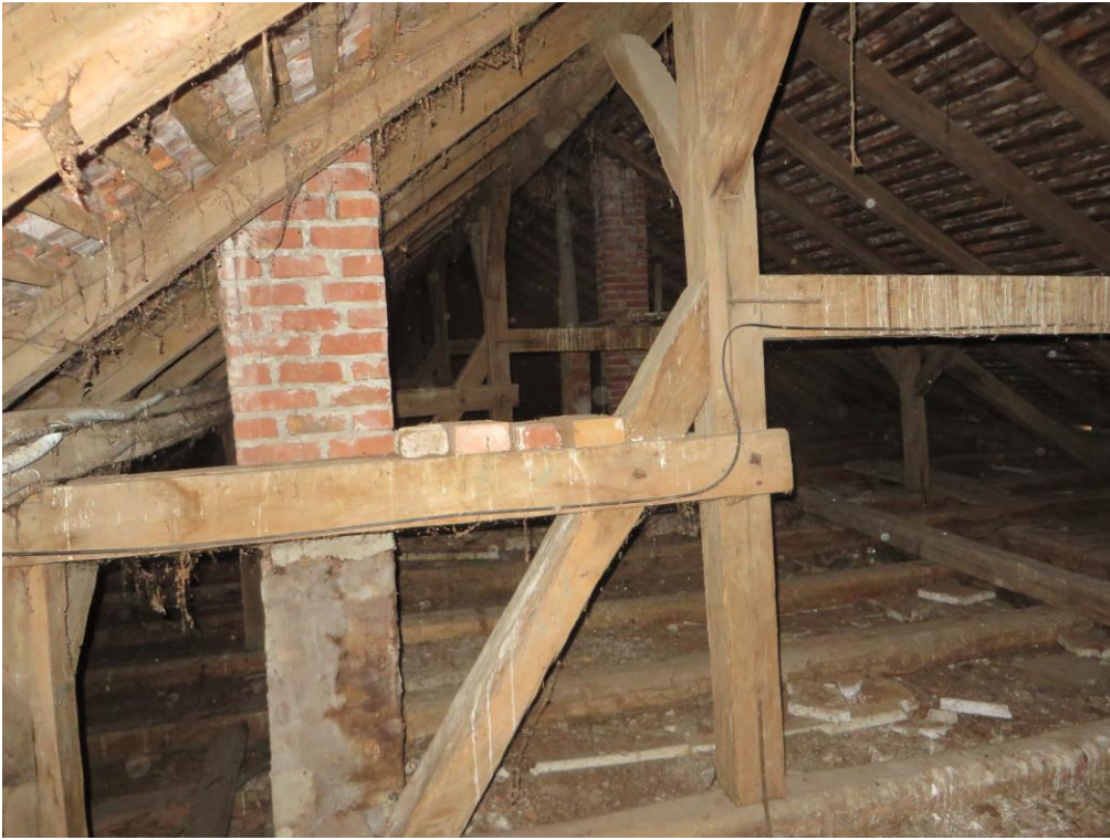
STROP I KATA STAROG DIJELA - DRVENI GREDNIK BEZ IZOLACIJE
