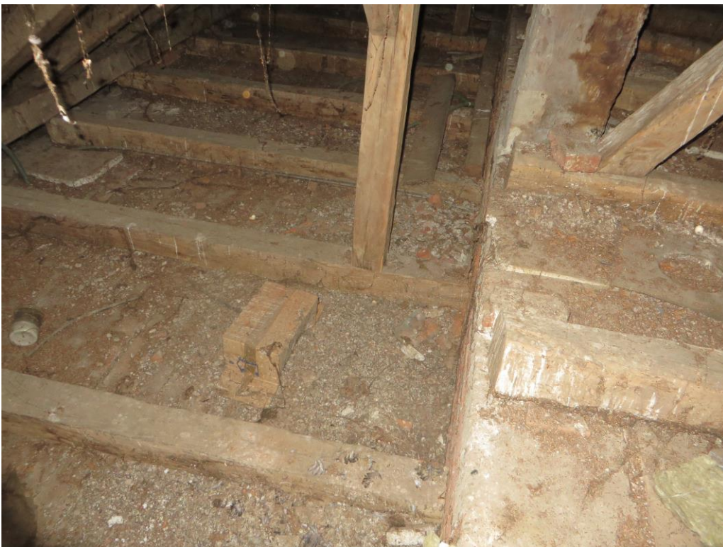
STROP I KATA STAROG DIJELA - DRVENI GREDNIK BEZ IZOLACIJE
